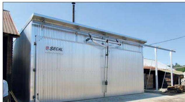
Für die erste Stufe der Weiterverarbeitung stehen zwei Dämpf- und drei Trockenkammern zur Verfügung.
